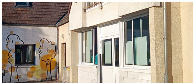
Rénovation des fenêtres et volets de deux classes, école Jean Rostand
