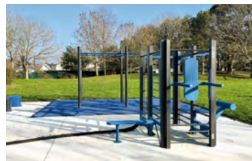
Plateau sportif au parc de loisirs (en cours de réalisation).
