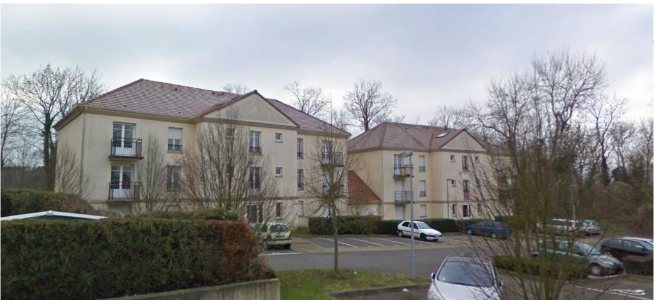
Les secteurs d'extension récents
