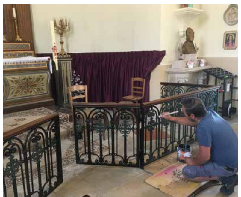
Travaux dans l'église (4)
