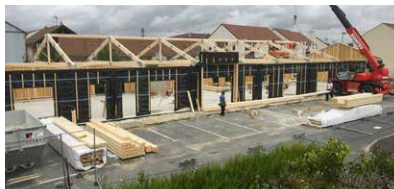
Travaux de la future maison médicale en cours
