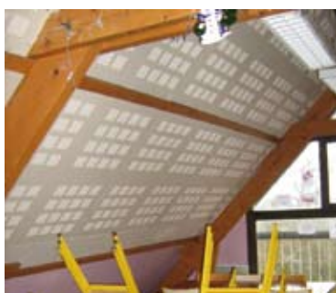
Travaux d'insonorisation Rostand
